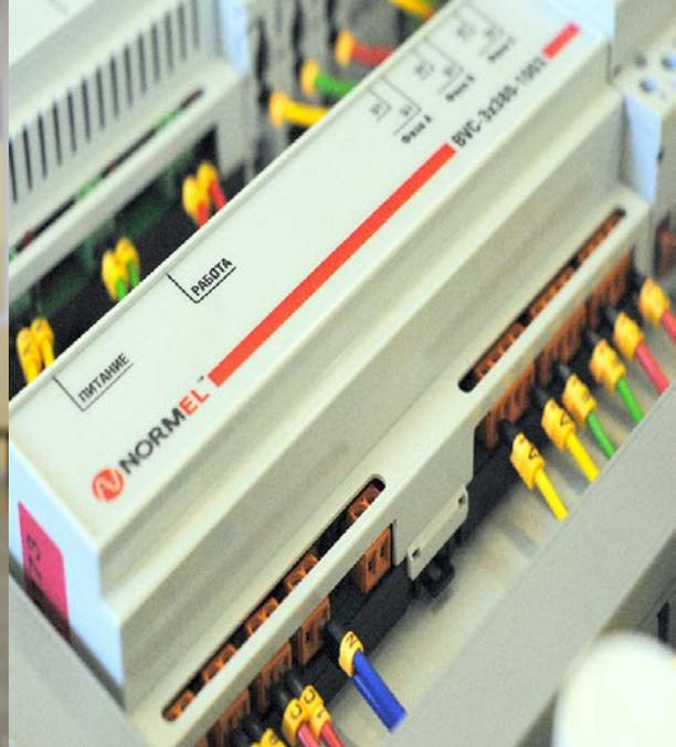
**Устройства - нормализаторы переменного напряжения** подключаются к электрическим вводам зданий, сооружений, промышленного оборудования, уличного освещения, т.е. любых потребителей электроэнергии в любой стране мира
